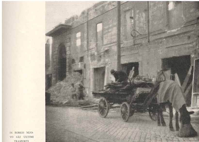
13. "The final transport from the Borgo Nuovo." Emilio Cecchi, "Psicologia delle demolizioni," Capitolium , vol. 12, no. 1 (1937), 31-38, 37.
